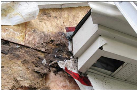
Les entrepreneurs doivent exiger une installation conforme aux recommandations des fabricants. Nous recommandons l'utilisation de systèmes avec double barrière et cavité de drainage et ayant obtenu un rapport d'évaluation du CCMC.
